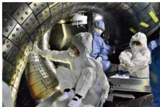
ドーナツ形状の真空容器の内側には、ヘリカルコイルと呼ばれる超伝導電磁石の入った壁が、らせん状に張り出しています。これを乗り越えて人が移動するのは大変なので、メンテナンスの最中は、横幅40センチメートルの橋が直径約8メートルのドーナツに沿って空中に架けられています。橋の上はちょうど、1億度近いプラズマが実験中に浮かんでいる位置です！見学者はチリやホコリを落とさないようにクリーンルームウェアを着て、真空容器の中を見て回りました。ステンレスでできた壁に直接接触すると、金属特有のひんやりとした感覚を体験できます。日常とは異なる空間の中で、時間が経つのを忘れ、写真を撮ったり、熱心にメモをとったりする姿がみられました。
